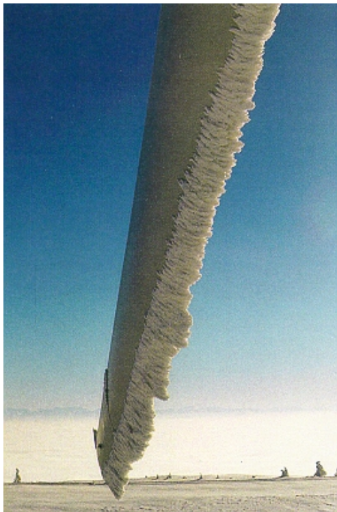
Figur 1 Ising på vindturbinvinge i Finland. Bildet er gjengitt med tillatelse fra Finsk Meteorologisk Institutt.
